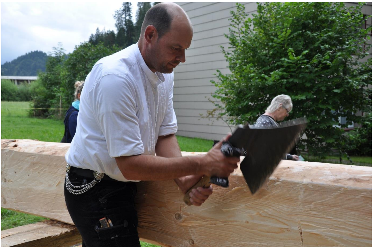
Der Holzbalken wird vom Zimmermann mit der Axt auf alte Art behauen
